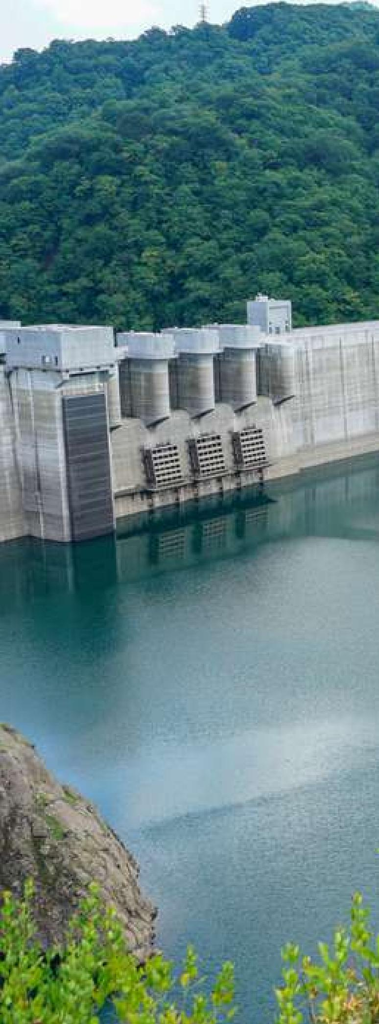
A usina, com capacidade de 270 MW, juntamente com uma microcentral hidrelétrica adicional de 5 MW, gera cerca de 1.170 GWh de eletricidade por ano
